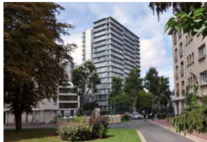
1 Tour Bois-le-Prêtre, à Paris avant travaux (© Lacaton & Vassal) 2 Tour Bois-le-Prêtre, Paris livrée en 2011. Architectes Frédéric Druot, Anne Lacaton & Jean-Philippe Vassal (© Frédéric Druot Architecture)
