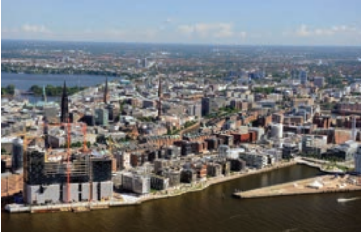
1 Vue aérienne du nouveau quartier Hafencity (©Elbe & Flut)
