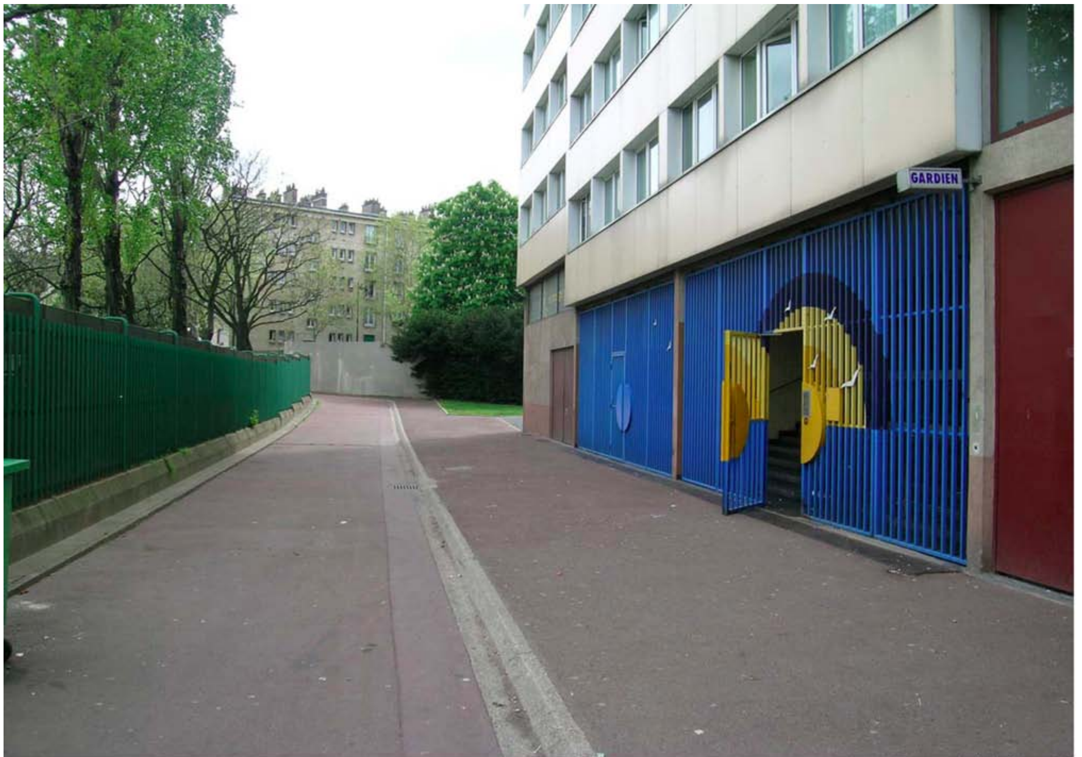
Existant : Accès de l'immeuble
