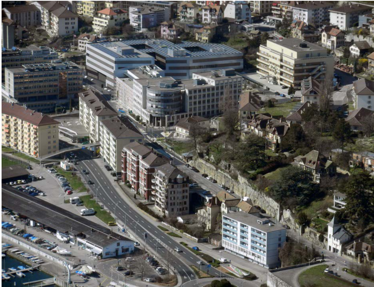
Centrale solaire en toiture (photo ERNE)
