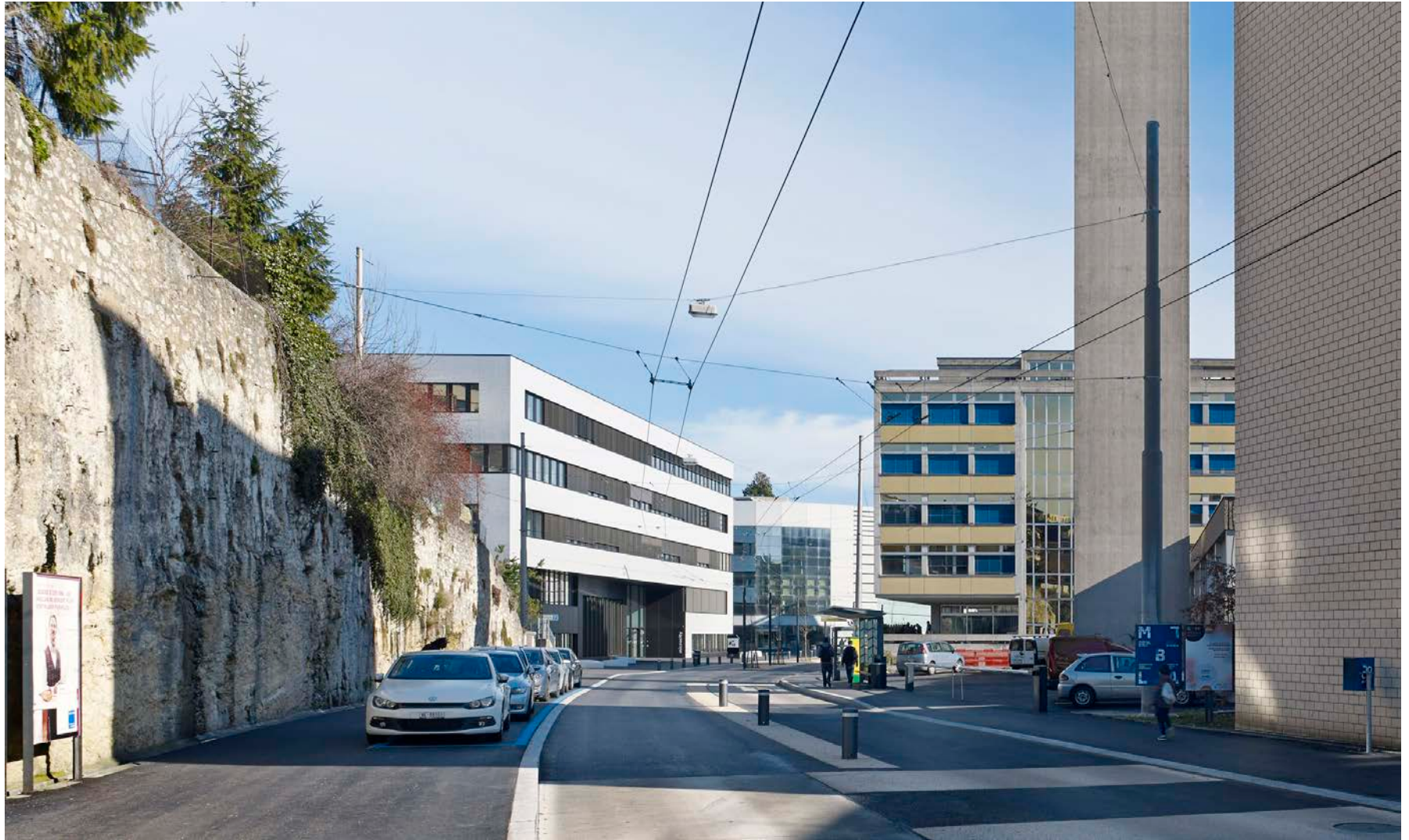
Réaménagement de la rue de la Maladière (photo Y. André)
